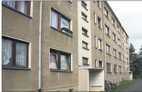
Nach Abschluss der derzeitigen Arbeiten wird auch noch der letzte verbliebene Wohnblock vollständig modernisiert. Bis vor ein paar Jahren sahen alle Blöcke im Löhmaer Weg so aus. Foto: A. Strauss
