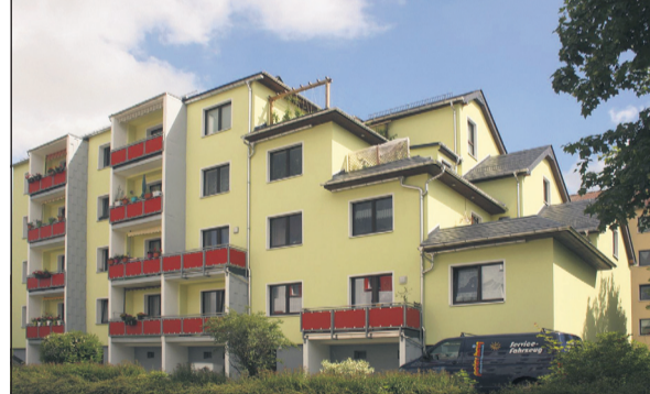
In den letzten Jahren wurden alle Wohnblöcke in der Straße saniert und sind nun nicht nur an die heutigen Bedürfnisse angepasst sondern präsentieren sich zudem sehr modern. Foto: A. Strauss
